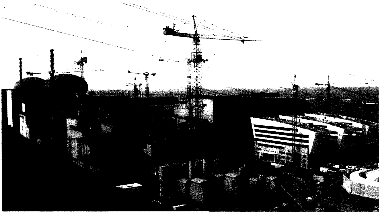
Lavori in corso. La centrale nucleare di Flamenville, in Francia, vede la partecipazione dell'Enel e costituisce il "prototipo" delle prime quattro centrali nucleari da costruire in Italia
